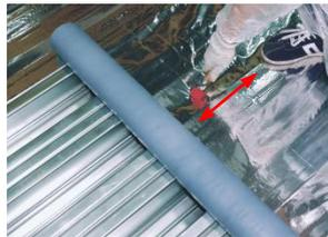
粘贴牢固后，缓缓打开整卷隔汽膜。
