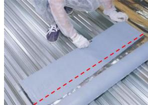
用裁纸刀在卷端处 30-40 厘米处切去硅化防粘膜。
