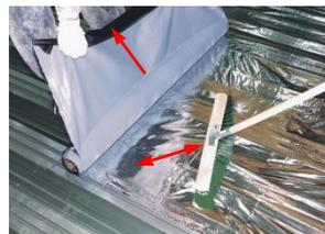
继续将隔汽膜粘贴于基层表面，一边将隔离膜去除，一边将隔汽膜刷平，确保于基层粘结牢固。
