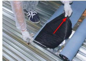
从卷端揭除隔离膜，将卷材粘贴于基层表面。
